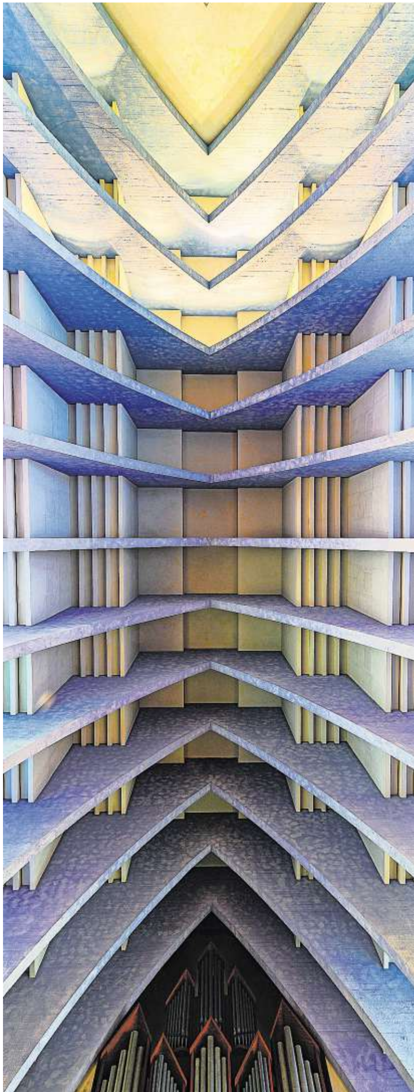
Die Kirche am Hohenzollernplatz in Berlin: „Innen findet man einen für die 30er Jahre modernen Stahlbetonskelettbau vor, der nur durch die farbige Verglasung so bunt erscheint“, erklärt Jürgen Krall. FOTO: JÜRGEN KRALL
